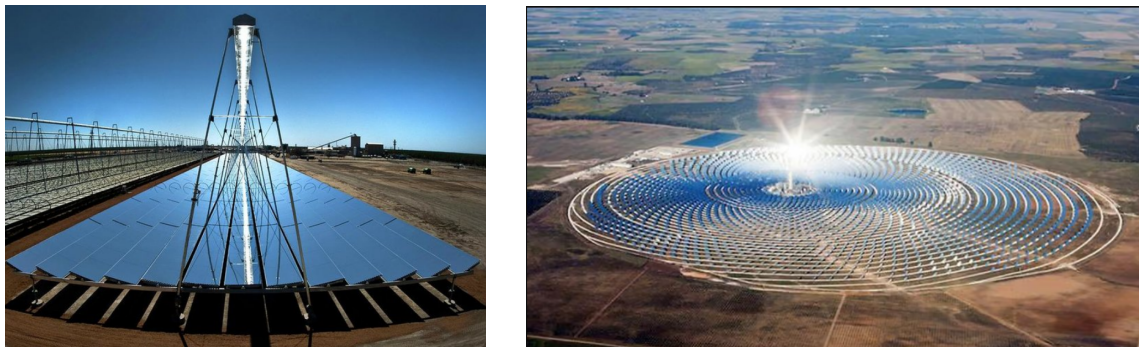
Figura 1.5: Fotografías de un concentrador lineal tipo Fresnel (izquierda) y uno de torre central (derecha). Extraídas de Fine Art America, 2025 y SolarPACES, 2025 respectivamente.
