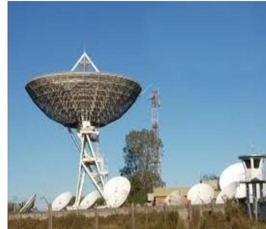
Receptor en Estación Manga (ANTEL)
